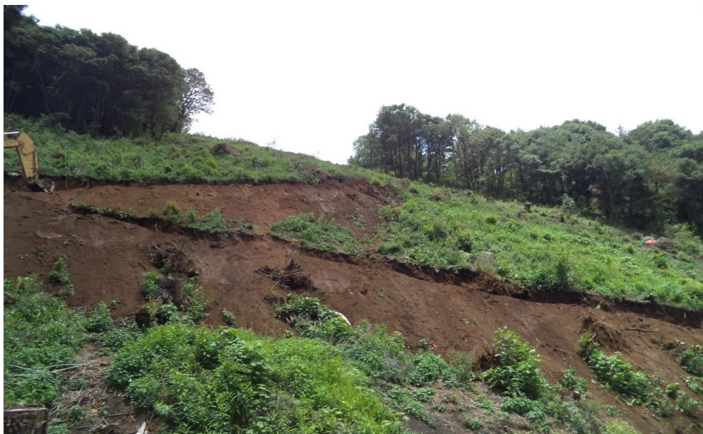
Figura 9: Trazando carretera. Este trazo representa la vista más evidente de la devastación cuando uno llega a la comunidad, aunque no la más grave. Aquí se observa el destrozo de la zona llevado a cabo existiendo amparos que restringen los trabajos en la zona sagrada. Fuente: memoria fotográfica del Colectivo Casa Común.
