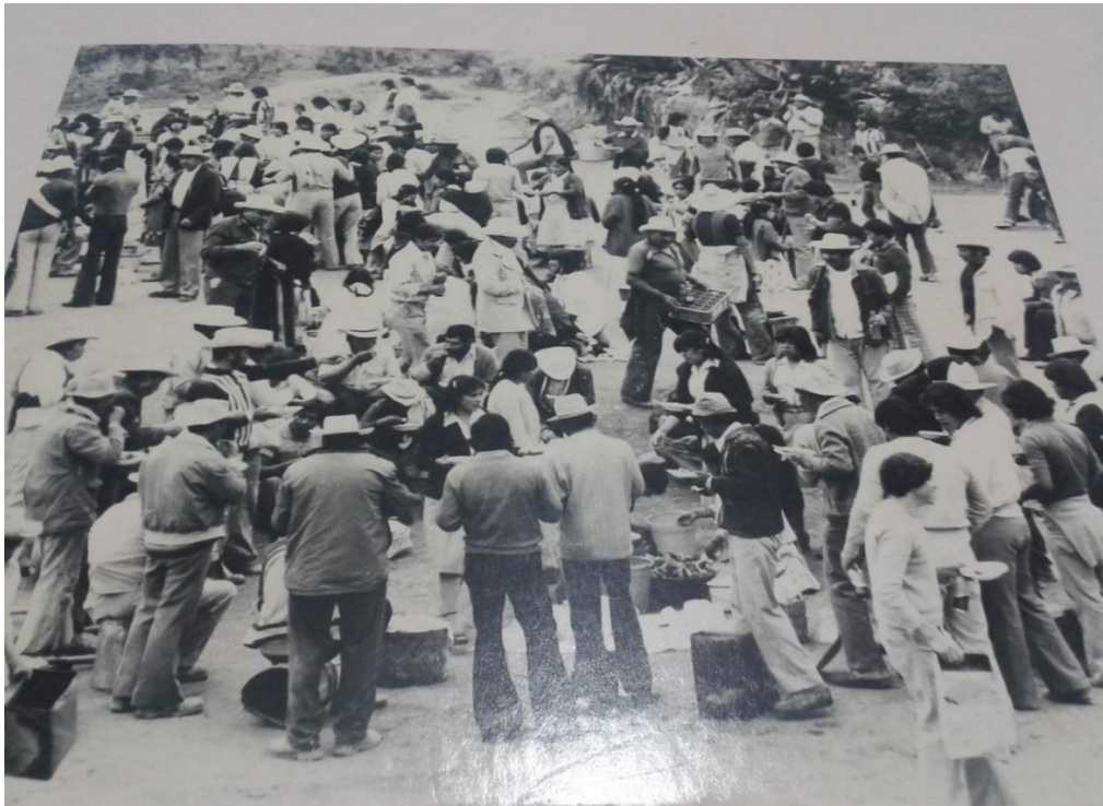
Figura 5: La faena. Comida durante la construcción de la iglesia de San Francisco Xochicuautla. La faena como parte de los trabajos colectivos en la comunidad, 1960 aproximadamente. Fuente: Documentos fotográficos de José Luis Fernández.
