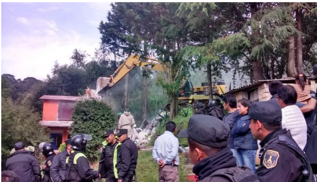
Figura 9.1. Derribo de algunas casas de la zona alta de la comunidad. Esta es quizá un de las imágenes que muestra uno de los momentos más tensos para los vecinos de la comunidad. Fuente: memoria fotográfica del Colectivo Casa Común.
