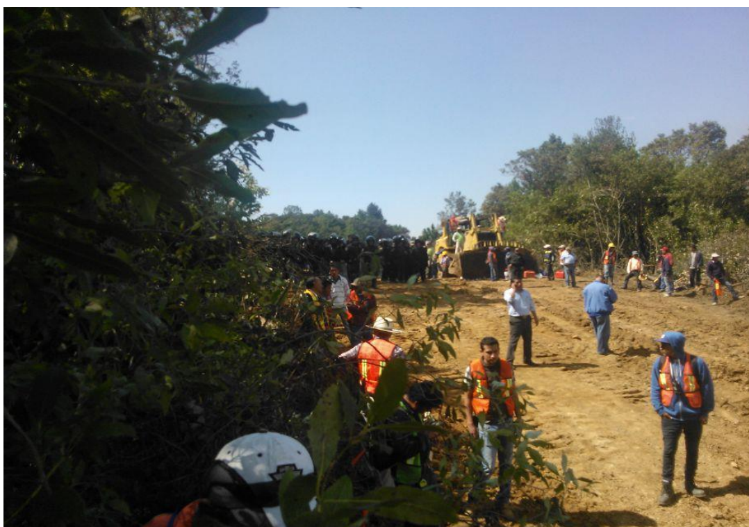
Figura 6: Abriendo brecha con granaderos. Trabajos de la constructora Teya, se puede observar el resguardo que las máquinas y los trabajadores tienen por parte de los granaderos. Noviembre de 2014. Fuente: memoria fotográfica Colectivo Casa Común.
